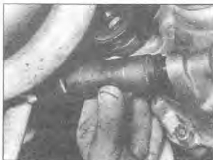
4.19 Вгоните сальник валика поводка в рабочее положение, используя трубчатую выколотку типа гнезда
