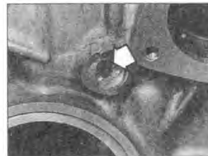
12.4 Очистите все смазочные канавки блока цилиндров (стрелкой отмечен масляный жиклер приводной цепи)
