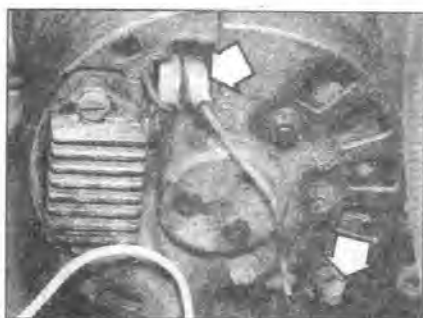
6.2 Соединения электропроводки генератора (отмечены стрелками)
