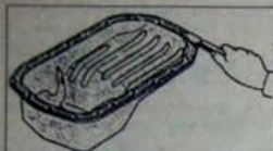
11.13 Очистка уплотнительной поверхности поддона
