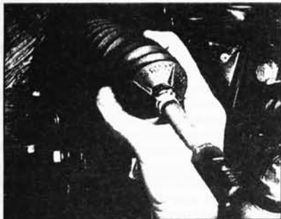
40 Проверка состояния и надежности крепления защитных чехлов рулевой рейки
