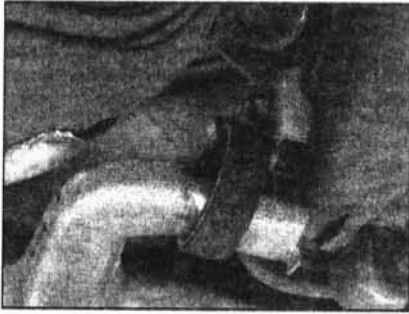
13.2 Осмотрите резиновые подвесы системы выпуска отработавших газов на наличие трещин
