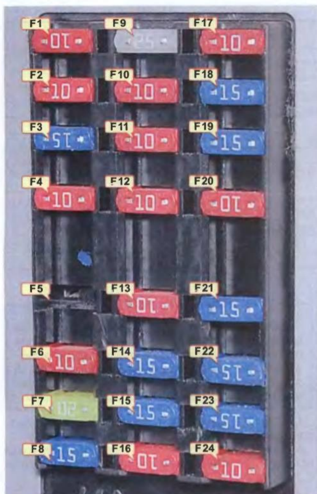
Монтажный блок предохранителей, расположенный в салоне
